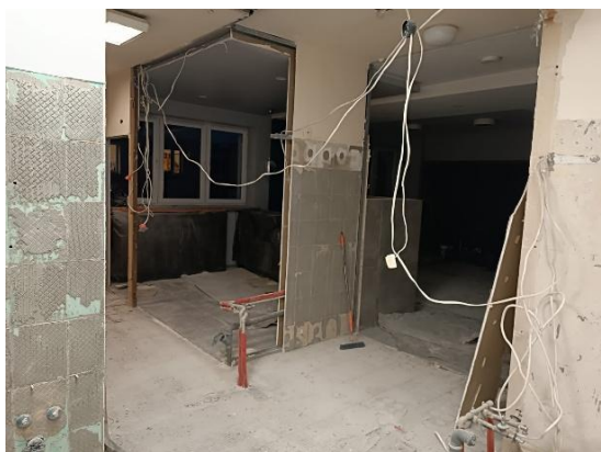
Kuchnia w trakcie remontu
