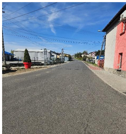
Przebudowa ul. Podleśnej w Czernicy
