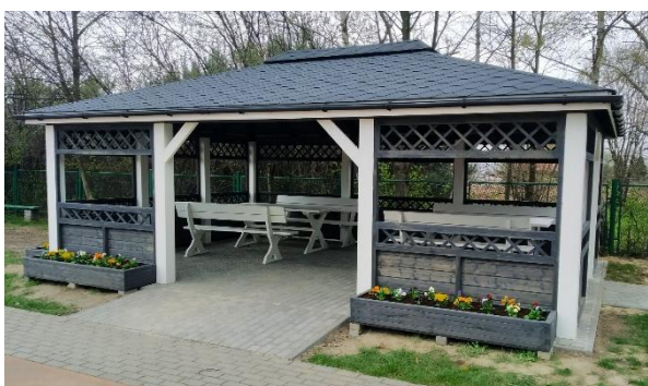
SP Gaszowice Budowa altany na placu szkolnym
