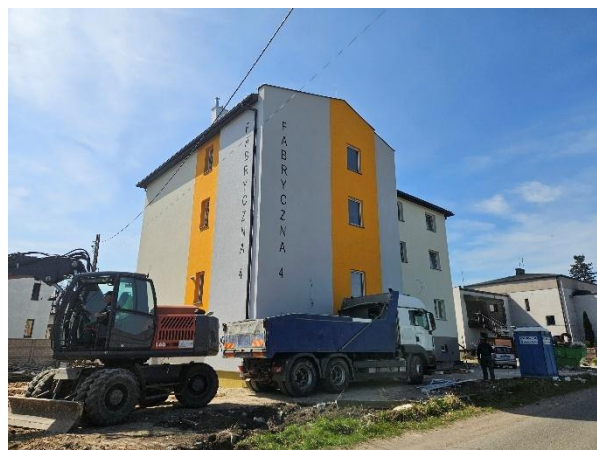
Budynek komunalny w Piecach
